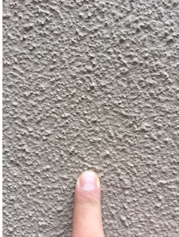
Brüt beton üzeri dekoratif sıvalı yüzeyler
